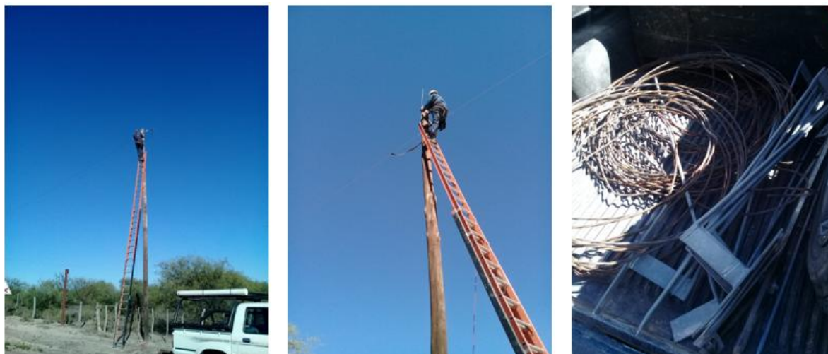
Trabajo de remoción de pararrayos en la zona de Monte de la provincia de Mendoza. Fotos: J. De Angelis
